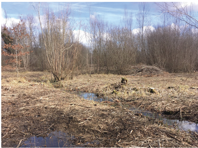
Restauration de la zone humide communale - Bray-sur-Seine - Mars 2019 (SEME)
