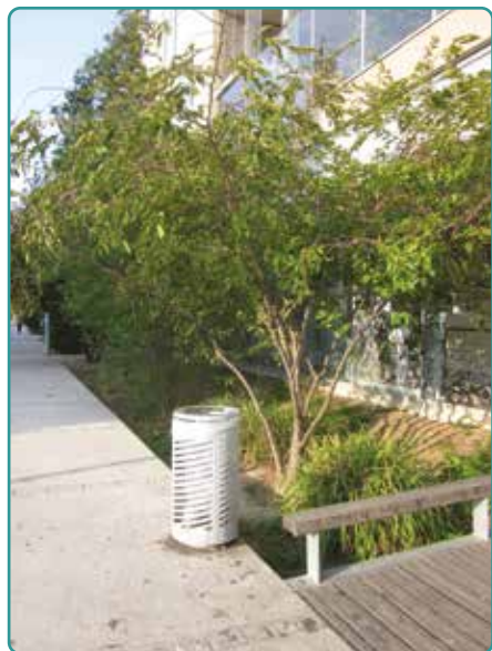
Noue pour l'infiltration des eaux de pluie
