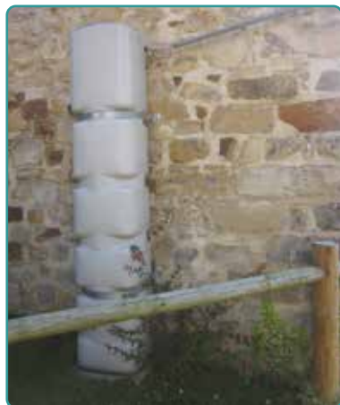
Cuve de récupération des eaux pluviales
