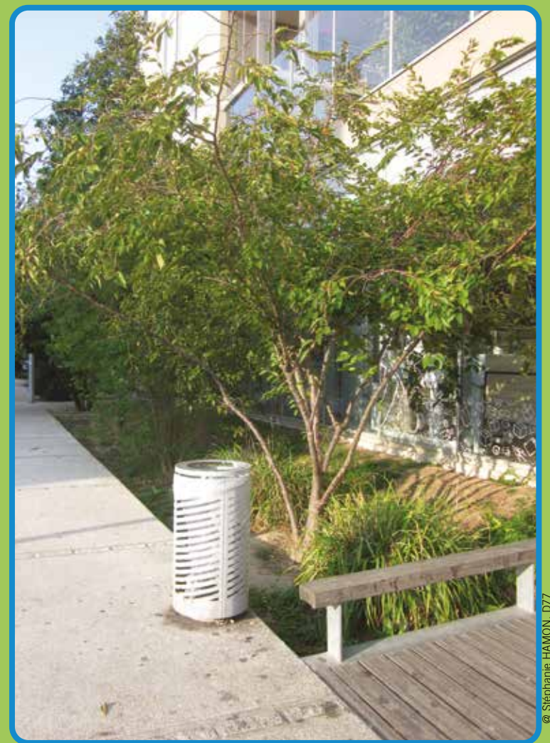
Noue pour l'infiltration des eaux de pluie
