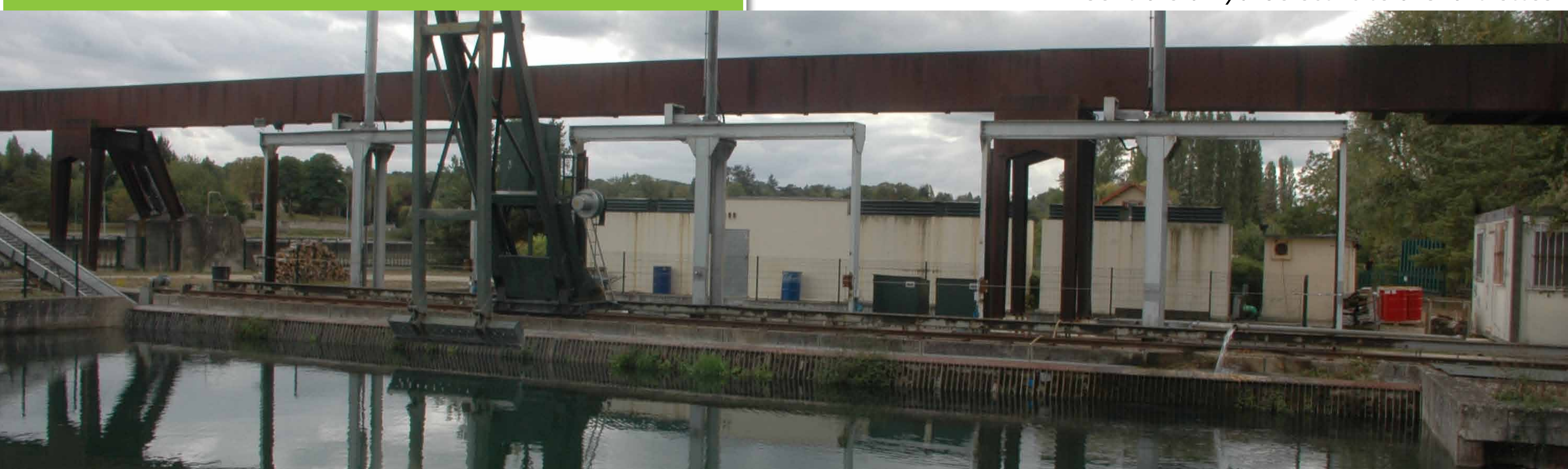
Centrale d'hydroélectricité à Chartrettes
