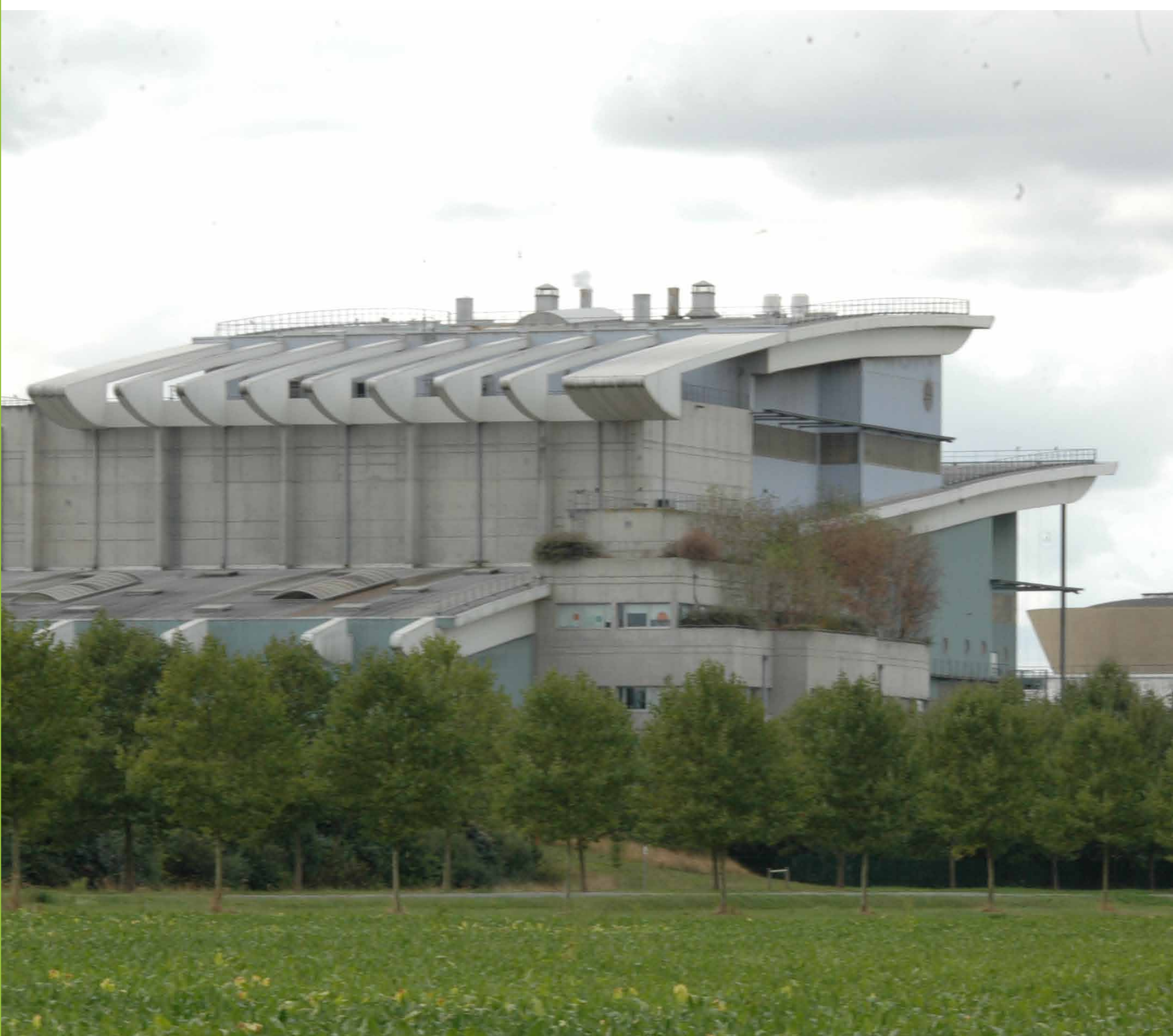
Centre de valorisation énergétique de Vaux-le-Pénil
