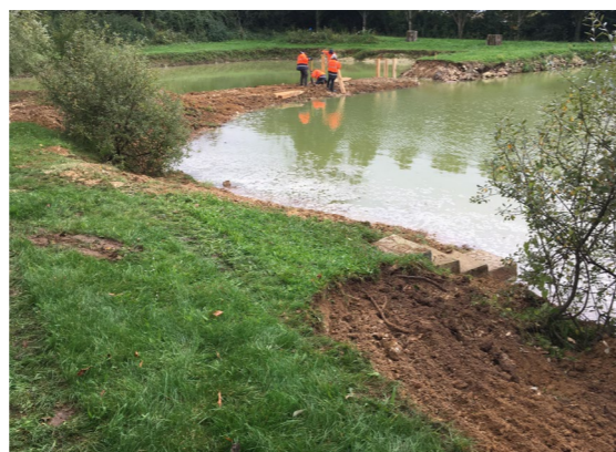
Planification et suivi de travaux sur deux mares communales - Beauchery-Saint-Martin - 2021
