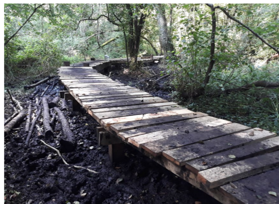
Platelage en cours à Villeneuve-sur-Bellot (Septembre 2021) - Crédit photo : SEME
