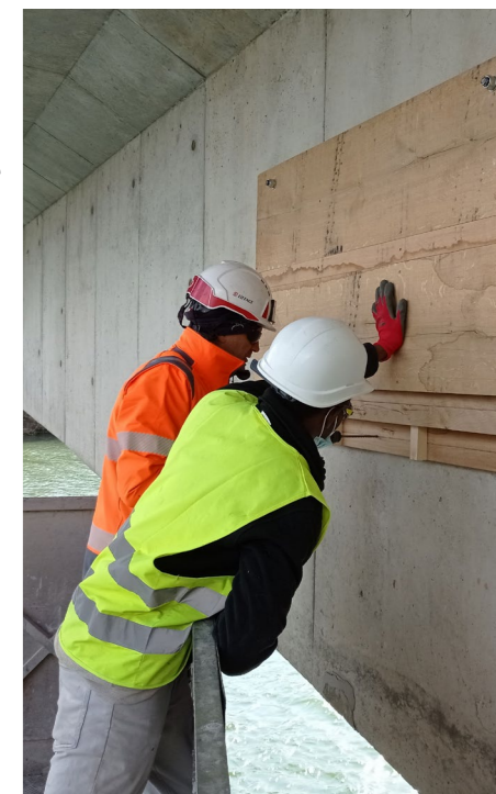
Installation gîte - Pont de Valvins - 2021 - Crédit photo : SEME
