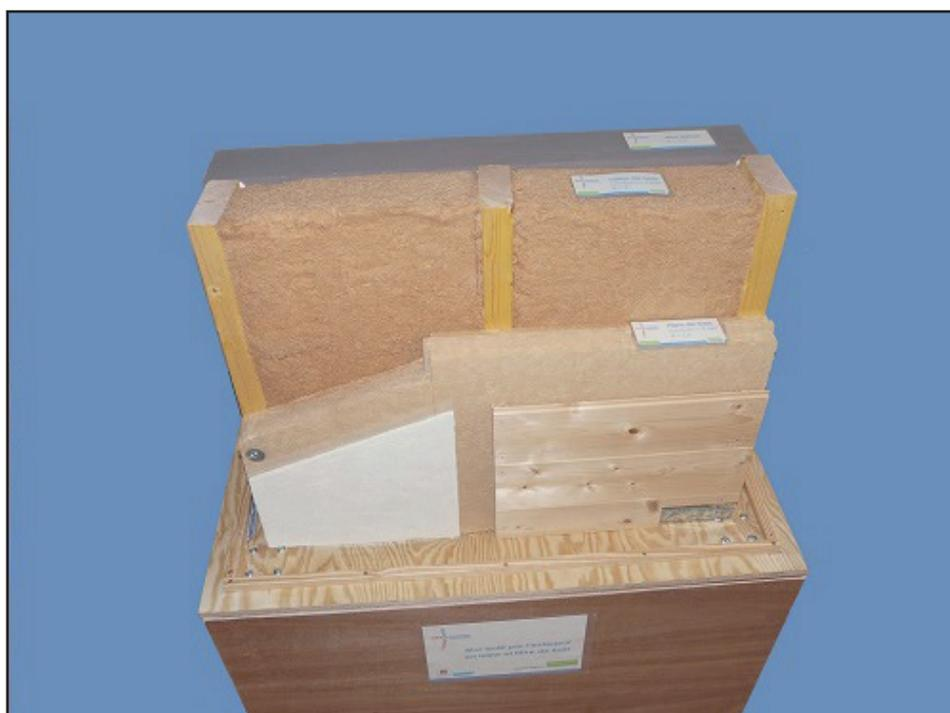
Mur isolé par l'extérieur en laine et fibre de bois
