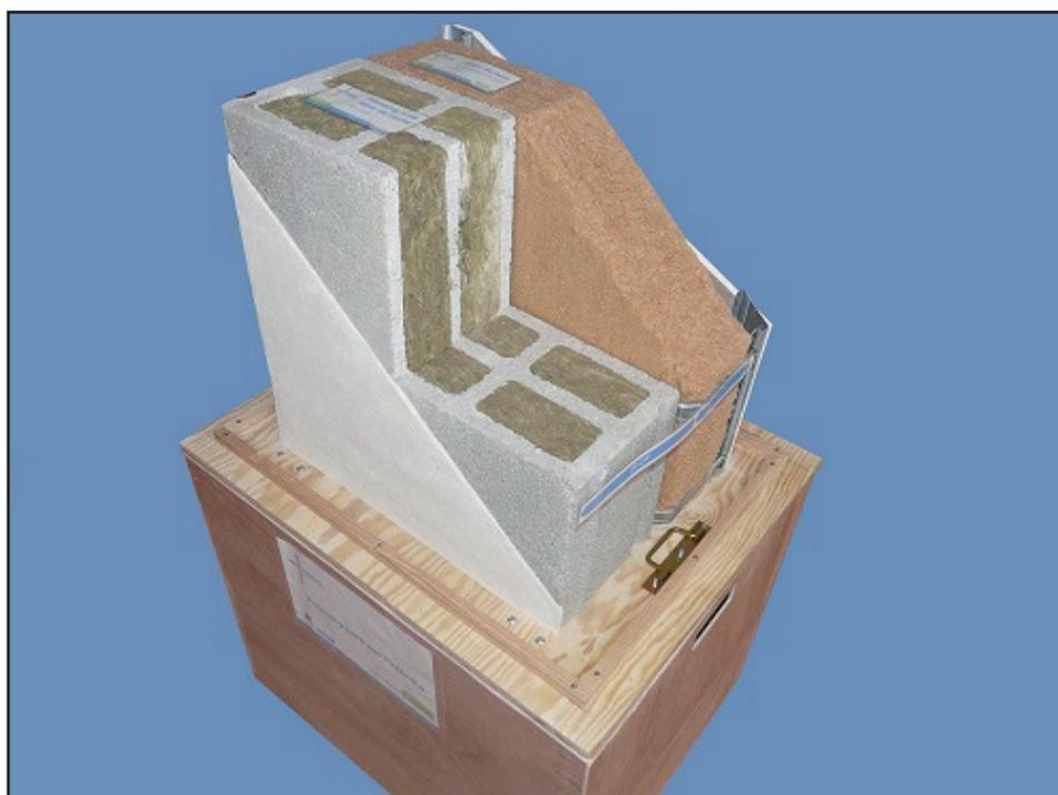
Parpaing isolé par l'intérieur en rouleau de laine de bois et parpaing pré-isolé à la laine de roche
