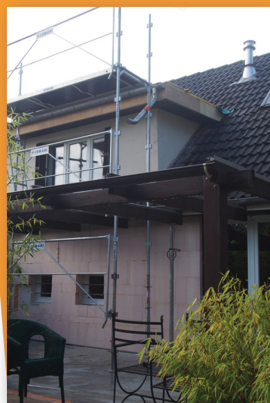
Isolation par l'Extérieur, village Bois-la-Croix, Pontault-Combault
